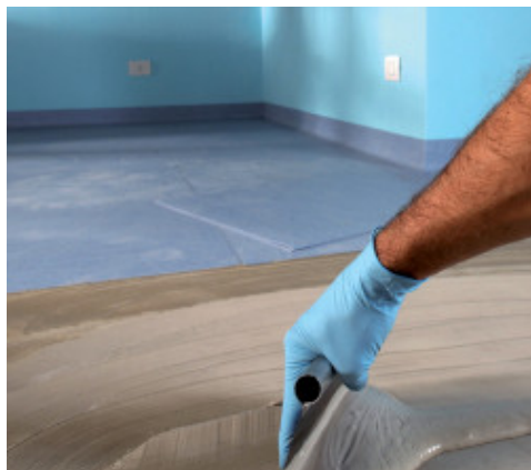
Aplicarea Ultrabond Eco 380
