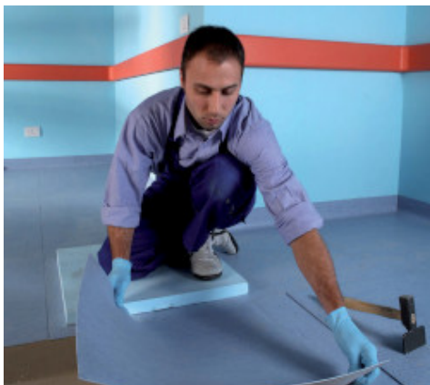
Montarea dalelor din PVC
